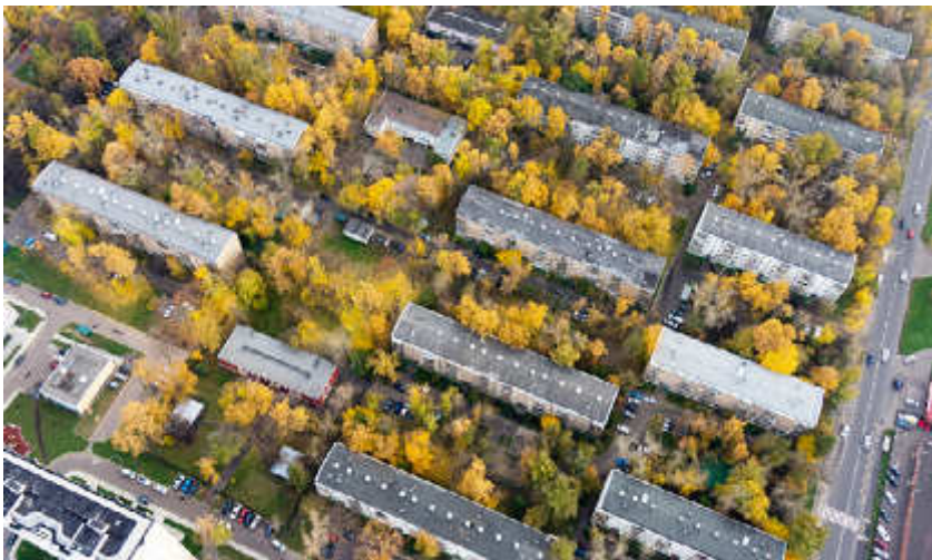
Микрорайонная застройка, г. Москва
